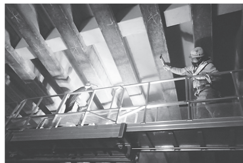
写真 - 3 高所作業車によるひび割れ調査
