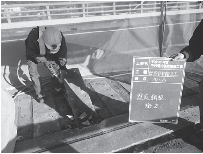
写真 - 5 補強鋼板撤去状況
