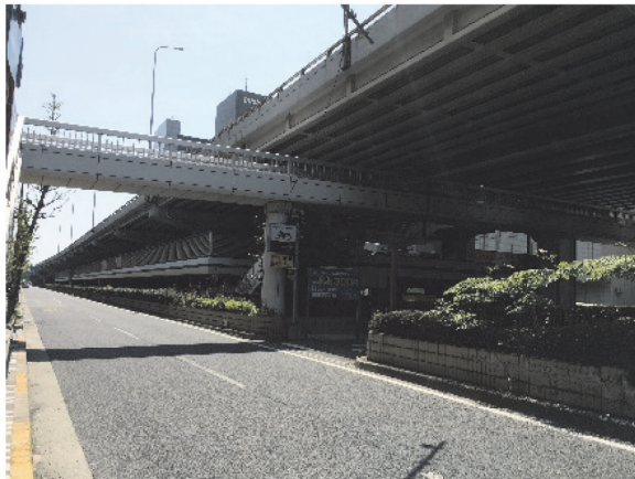
写真 - 11 橋梁下利用状況
