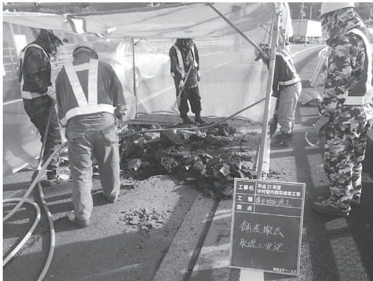
写真 - 8 仮設の囲い柵（メッシュシート）使用状況
