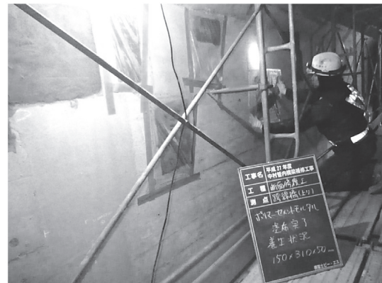
写真 - 10 マスキングシートによる養生
