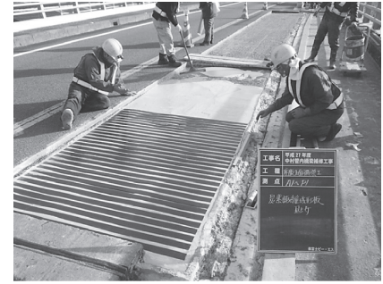
写真 - 7 炭素繊維成型板の配置状況
