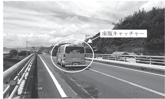
写真 - 4 非破壊検査状況
