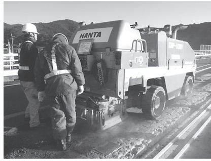
写真 - 6 床版切削状況
