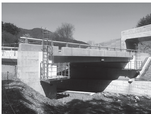
写真 - 16 不動沢橋全景
