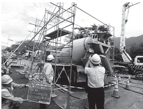
写真 - 15 待機場所での散水装置使用状況
