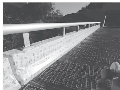
写真 - 13 地覆・壁高欄の養生状況
