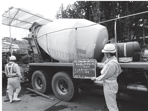
写真 - 14 ドラムカバー装着状況
