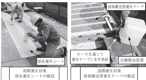
写真 - 10 実物大試験実施状況
