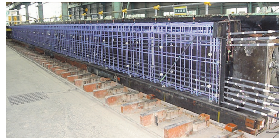
写真 - 1 高耐久仕様実物大試験桁製作状況
