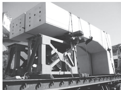
写真 - 5 端部ブロック運搬荷姿
