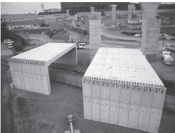
写真 - 11 門形カルバートの全景
