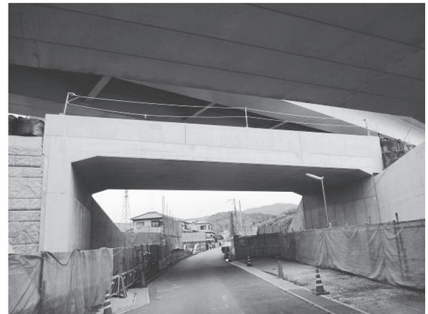
写真 - 12 完成時状況写真
