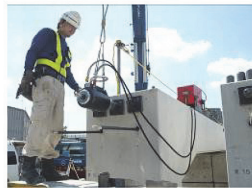
写真 - 8 ケーブル挿入状況と緊張作業状況
