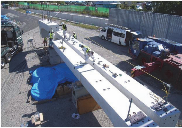
写真 - 7 セグメント部材の組立て状況
