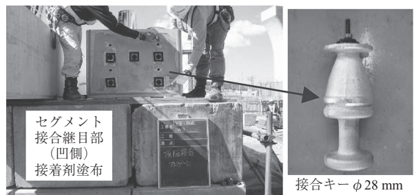
写真 - 6 接着剤塗布状況と接合キー
