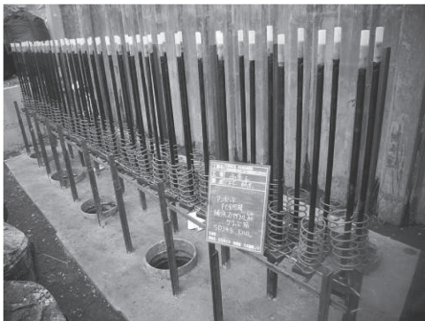
写真 - 4 アンボンド PC 鋼棒の建込み
