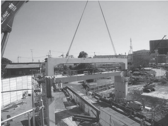
写真 - 10 頂版部材の架設状況
