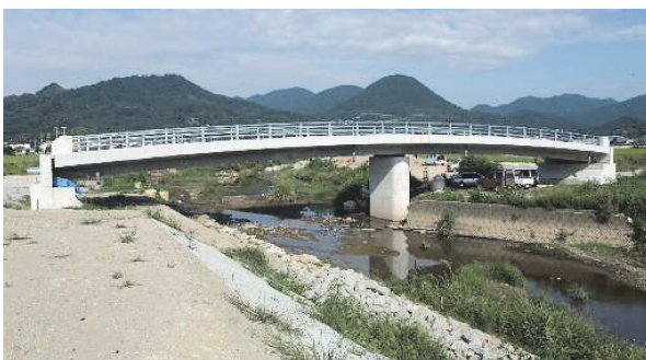
写真 - 1 橋梁全景
