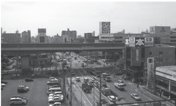
写真-1 喜連瓜破橋
