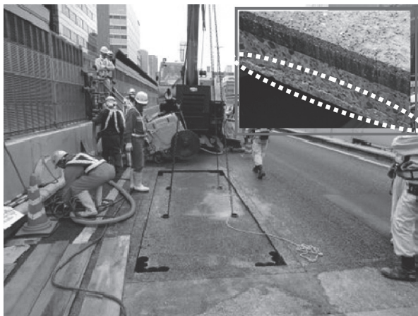
写真 - 5 RC 床版切出し状況 (右上は床版内部ひび割れ)
