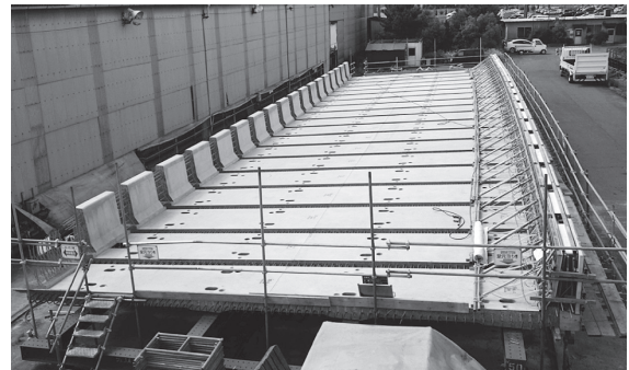
写真 - 3 仮組みによるプレキャスト壁高欄製作状況
