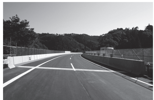
写真 - 12 完成写真
