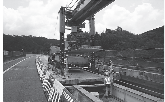
写真 - 2 架設装置によるPC床版の架設状況
