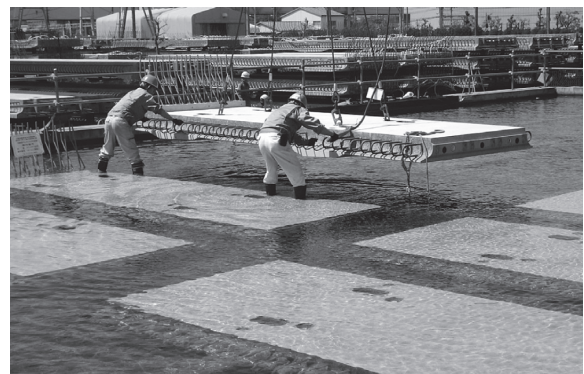
写真-6 床版の水中養生状況
