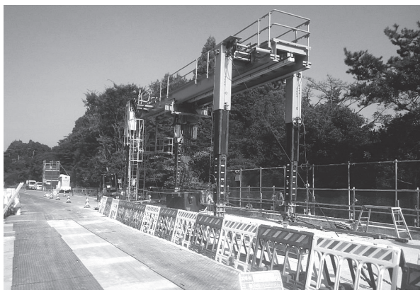
図 - 8 架設装置組立て完了
