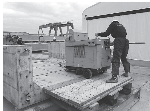
写真 - 7 床版乾式切断施工試験状況
