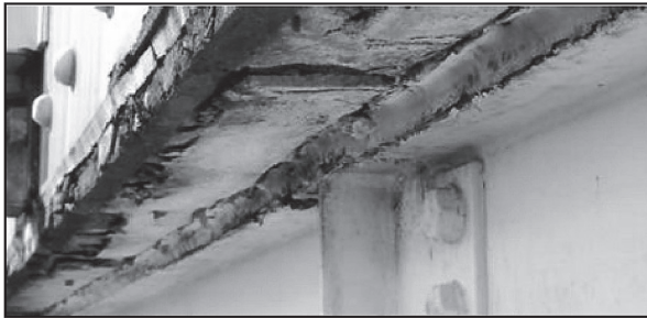
写真 - 2 壁高欄の下面
