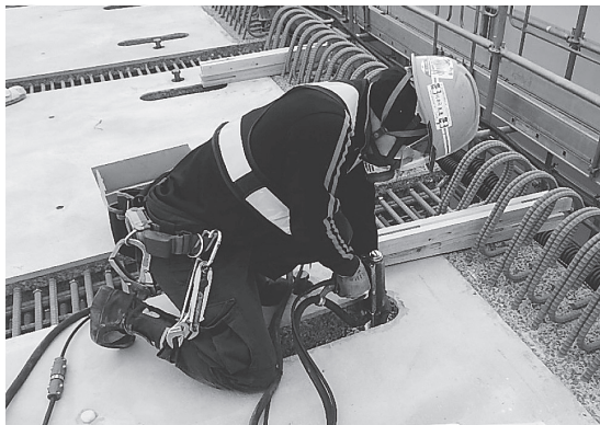
写真 - 3 スタッドジベル設置状況
