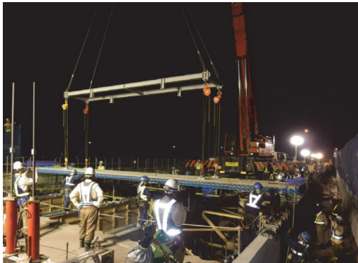
写真 - 8 PCa床版架設状況
