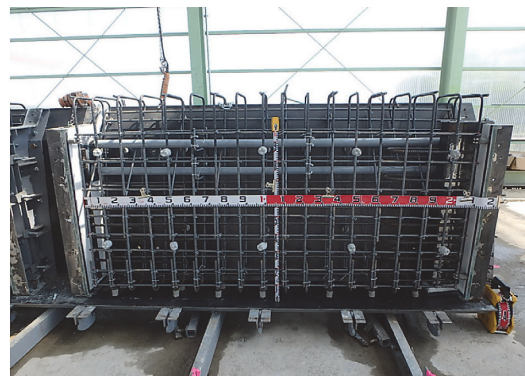
写真 - 10 プレキャスト壁高欄製作状況
