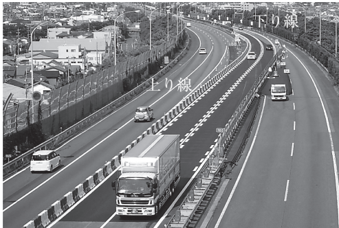
写真 - 6 対面通行規制（シフト部）
