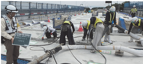
写真 - 9 コンクリート打設状況
