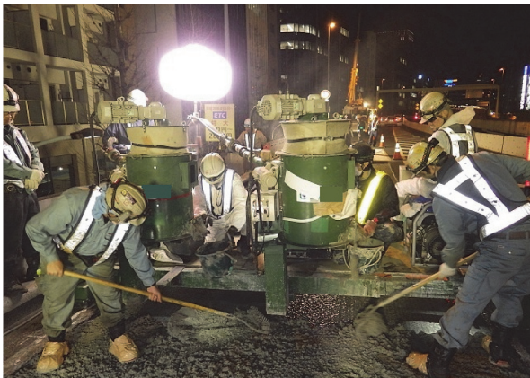
写真 - 2 PCM 舗装施工状況
