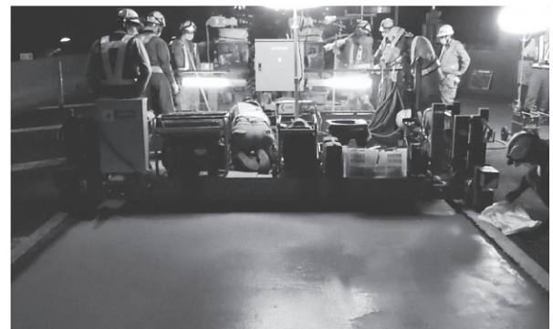
写真 - 5 専用フィニッシャーによる仕上げ状況
