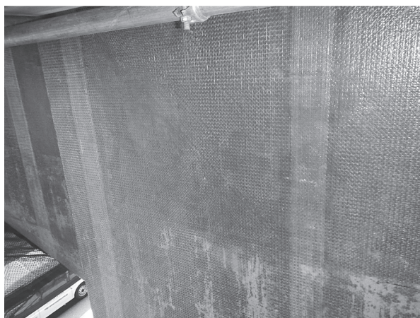
写真-4 表面保護工（繊維シートあり）の施工状況
