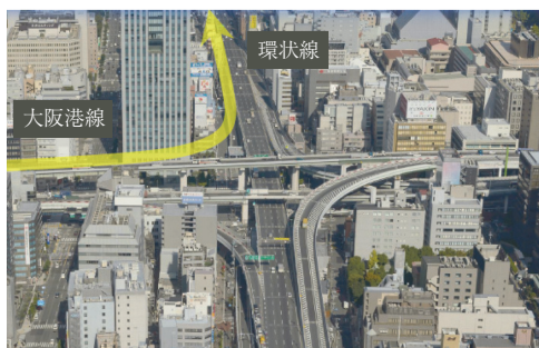
写真 - 1 西船場 JCT の事業箇所
