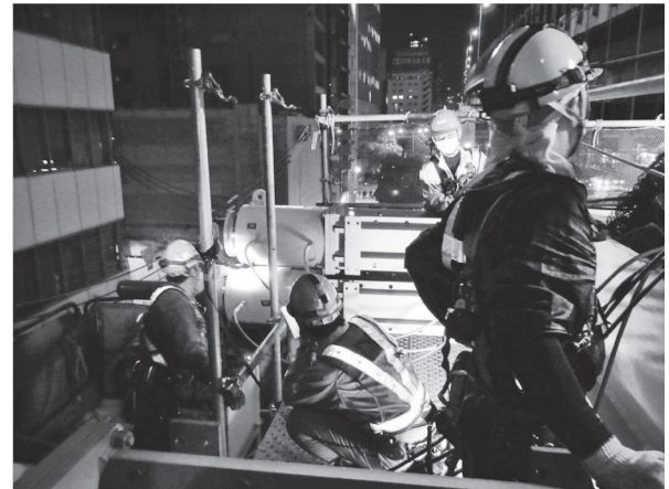
写真 - 8 外ケーブルの緊張状況
