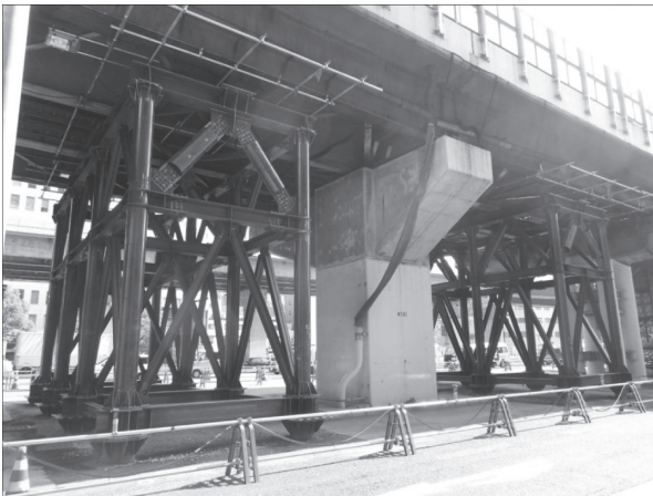
写真 - 10 仮受け構台設置状況
