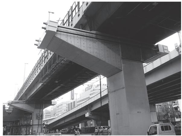
写真 - 12 梁拡幅完了状況
