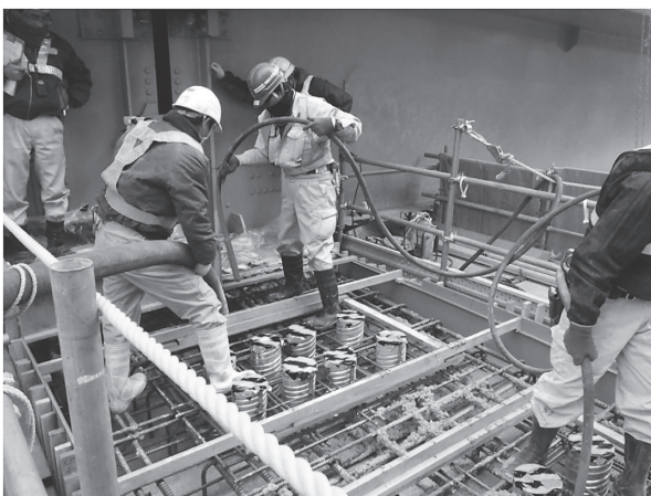
写真 - 7 高流動コンクリート打設状況
