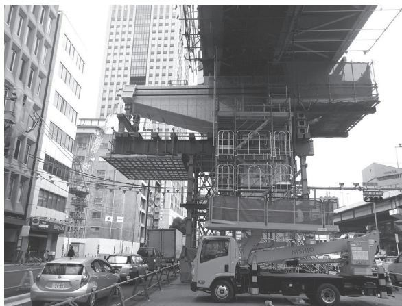
写真-5 張出し支保工設置状況
