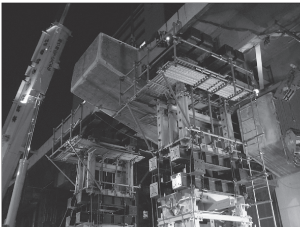
写真 - 11 梁撤去状況
