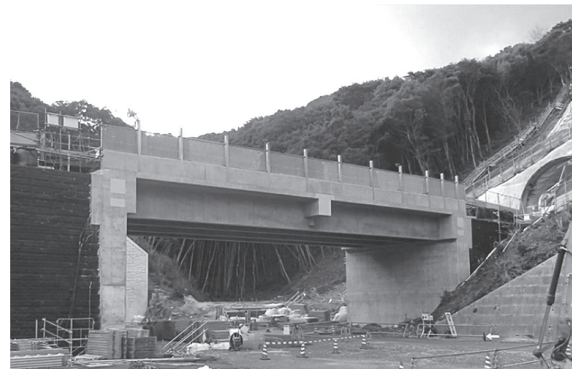
写真 - 2 現地の施工状況
