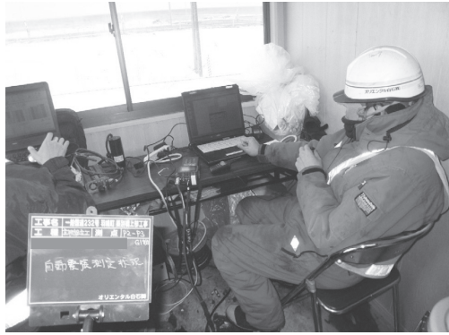
写真 - 12 パソコンを用いた緊張管理状況
