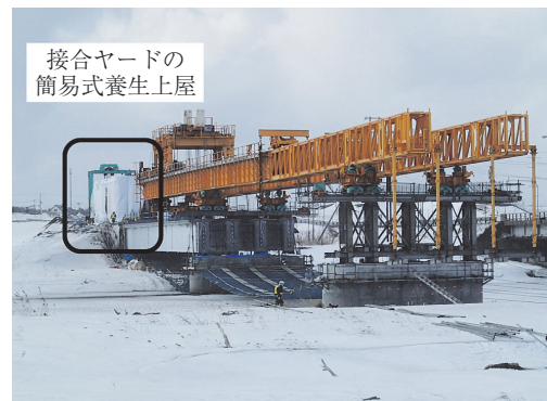
写真 - 11 二径間目への架設桁移動完了状況
