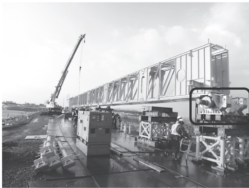
写真 - 4 電動送りローラー
