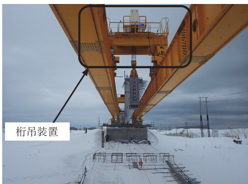
写真 - 8 主桁の引出し状況
