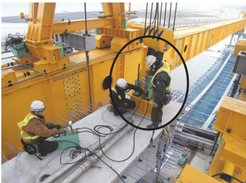
写真 - 7 桁吊金具取付け
