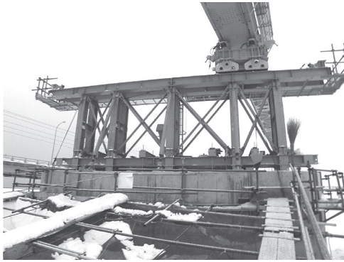
写真 - 3 橋脚ペントの組立て完了状況
