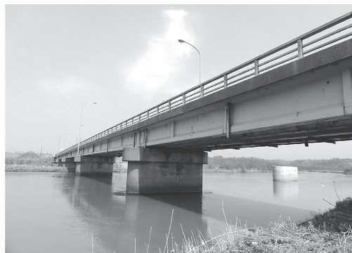
写真 - 1 旧築別橋全景
