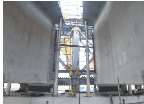
写真 - 10 架設後の主桁の固定状況
