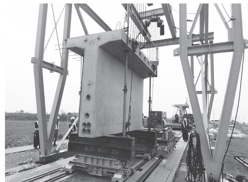
写真 - 6 定置式クレーンと調整台車
