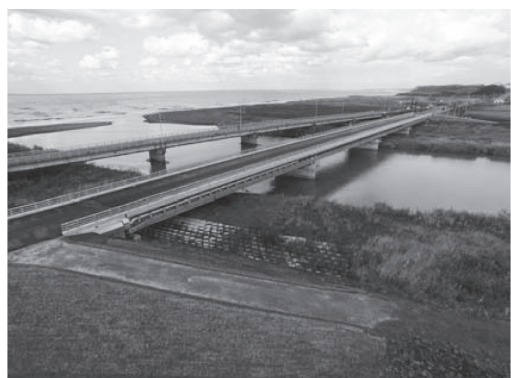
写真 - 14 築別橋完成 (ドローンパイロット 請川博一氏撮影)
