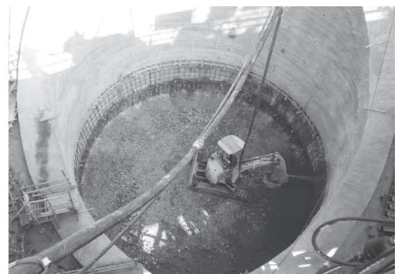
写真 - 5 施工状況（コンクリート吹付け）
