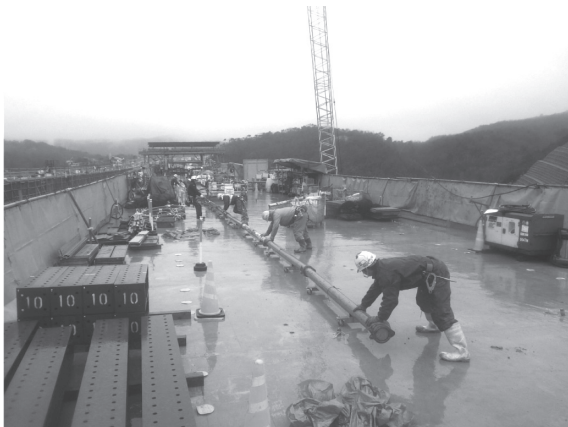
写真 - 10 コンクリート配管盛替状況
