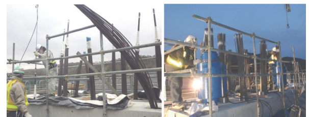
写真 - 9 仮固定PC鋼より線の挿入・緊張状況
