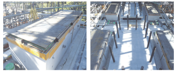
写真 - 8 仮支承設置状況
