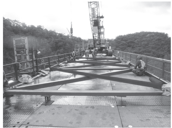
写真 - 3 ブレース地組状況
