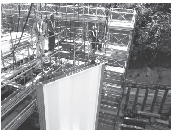
写真 - 11 波形鋼板ウェブ設置状況
