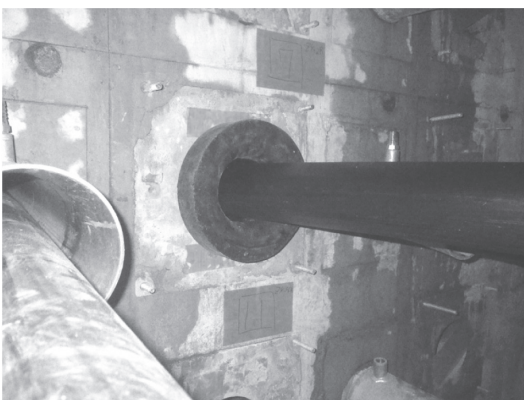
写真 - 15 挿入用特殊治具その1 （偏向管部の保護）
