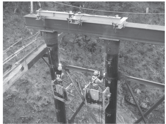
写真 - 4 ゴンドラ使用によるブレース設置状況
