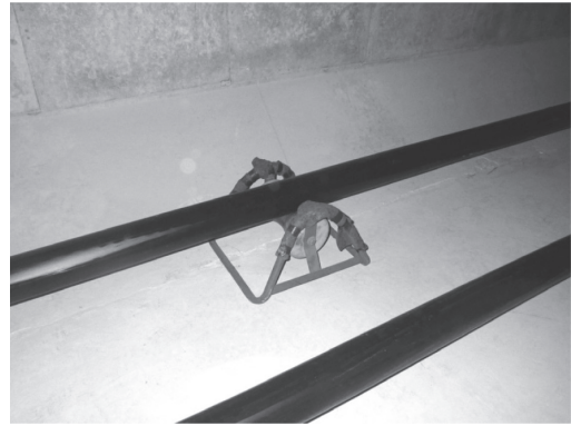
写真 - 16 挿入用特殊治具その2 （設置高低い箇所部の保護）
