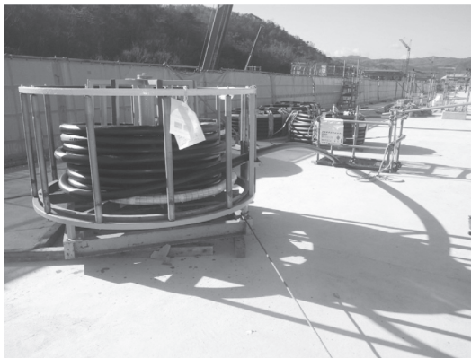
写真 - 14 外ケーブル挿入状況
