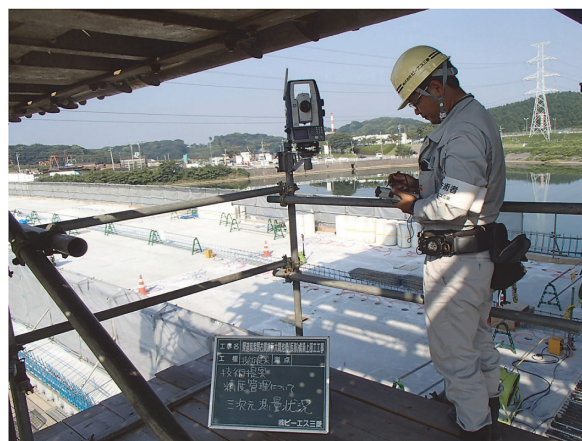
写真 - 5 トータルステーション計測
