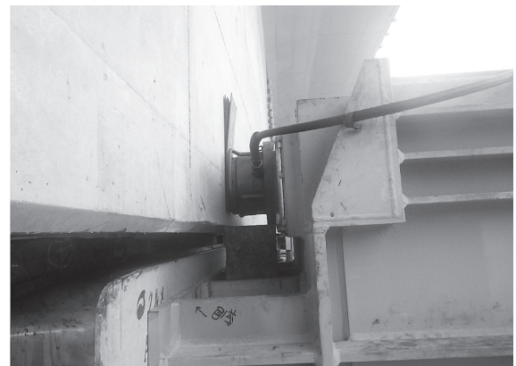
写真 - 8 横方向ジャッキ
