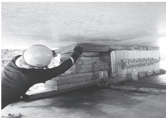
写真 - 4 押出し状況 (滑り支承部)
