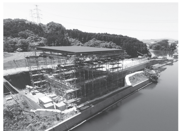
写真 - 2 主桁製作ヤード
