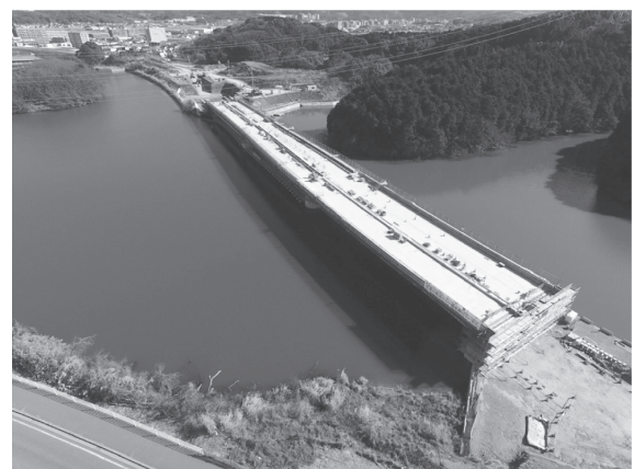
写真 - 9 現況写真
