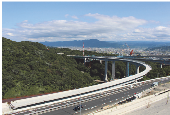
写真 - 10 完成写真 (2)
