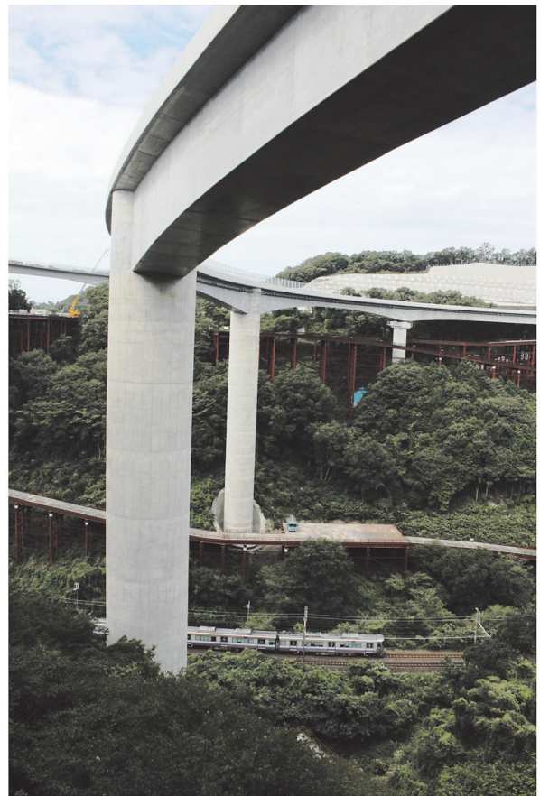
写真 - 9 完成写真 (1)
