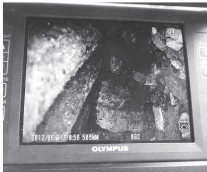
写真 - 1 対象橋梁のグラウト充填不足部における PC 鋼材の腐食状況例 (No.3 ケーブル終点側)
