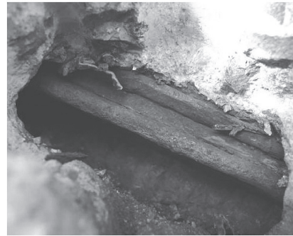
写真 - 1 対象橋梁のグラウト充填不足部における PC 鋼材の腐食状況例 (No.3 ケーブル終点側)
