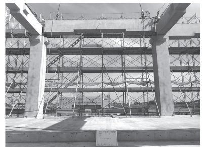
写真 - 6 PC 大梁の架設状況
