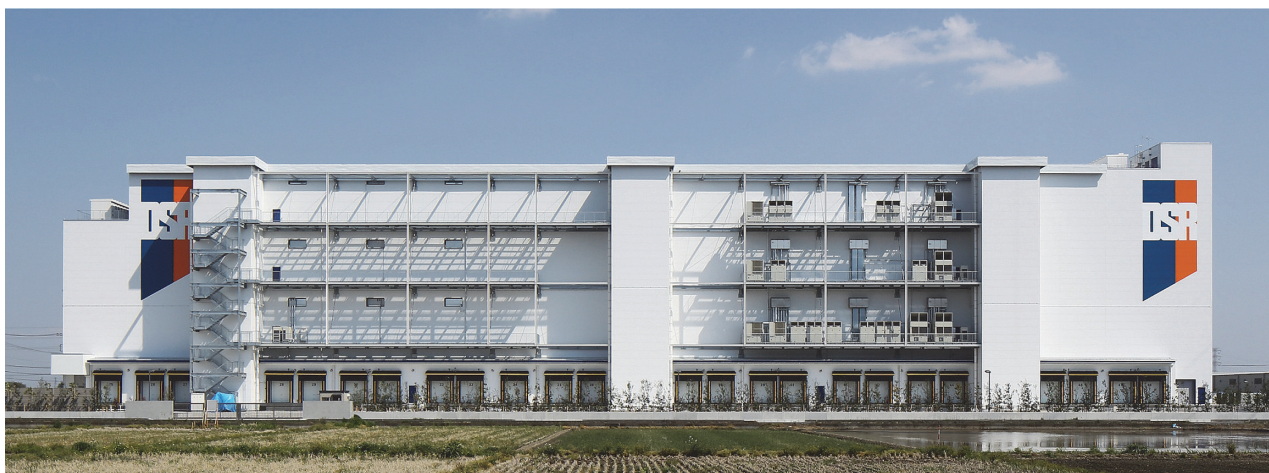
写真 - 1 外観写真*
