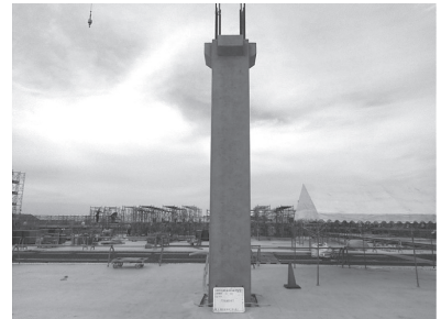
写真 - 5 PC 柱の自立
