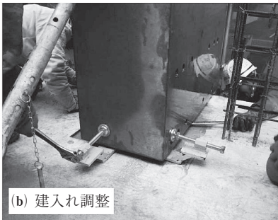
写真 - 5 PCaRC 柱の架設および建方完了状況
