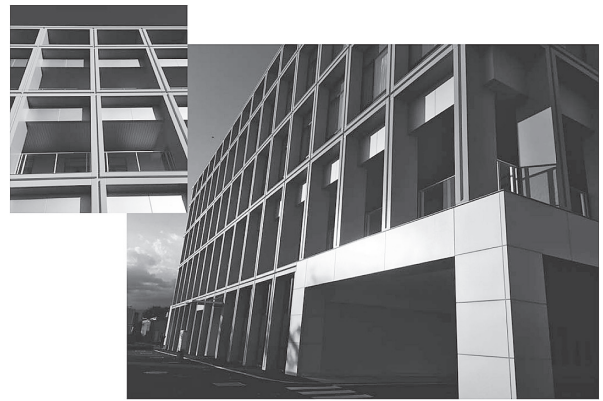
写真 - 10 建物全景（南面）
