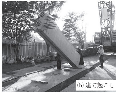
写真 - 4 PCaRC 柱仮置き, 建て起こしおよび吊上げ状況
