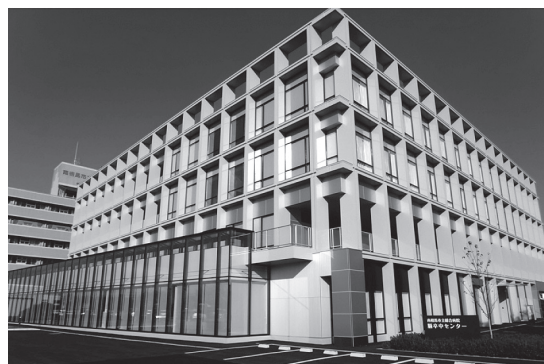
写真 - 1 建物外観（南西面）
