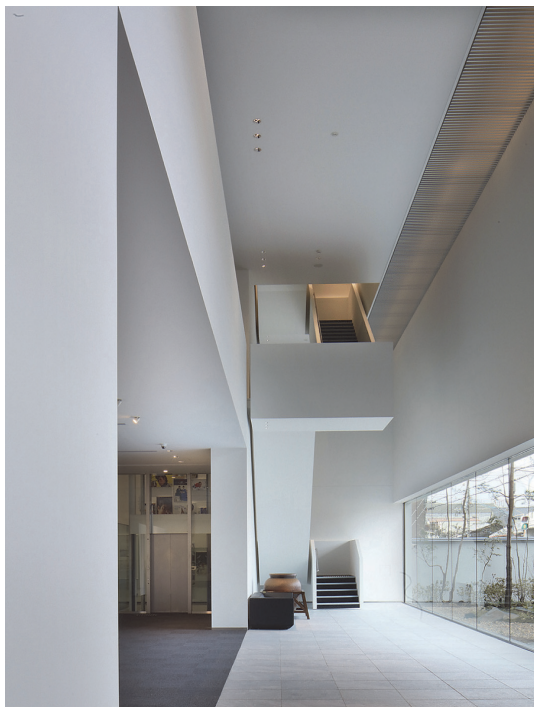
写真 - 6 側壁面とは切り離れたトラス階段
