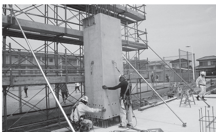
写真 - 6 A. PCa 柱建方
