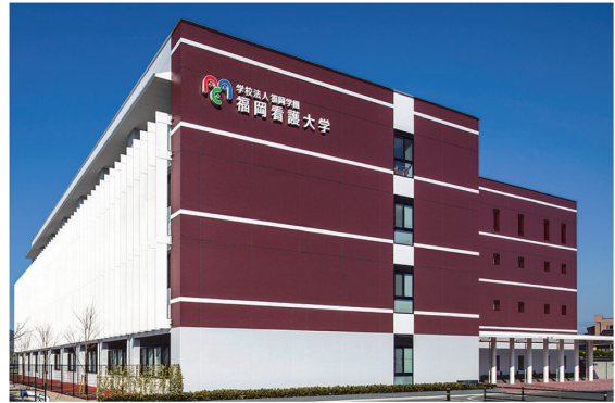
写真 - 14 外壁外観
