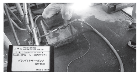
写真 - 13 L. PCaPC 梁ケーブルグラウト
