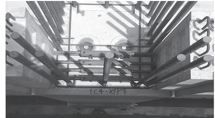
写真 - 9 D. 下端筋主筋機械式継手
