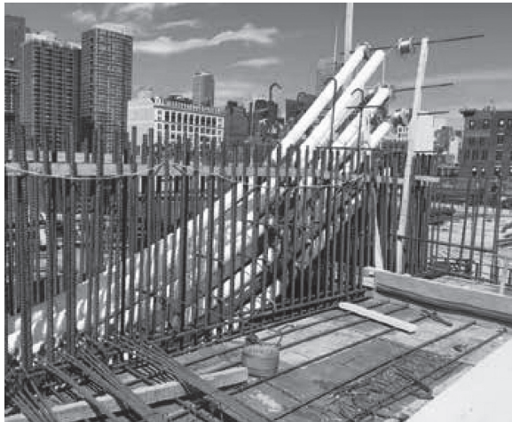
図 - 8 8階トランスファーウォール部施工状況
