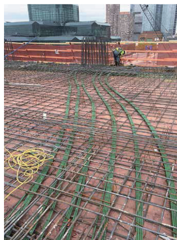
図 - 4 PC 鋼材と普通鉄筋の床配筋
