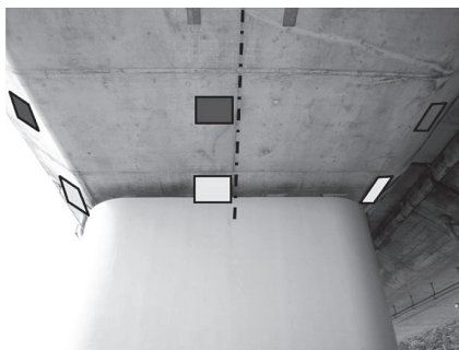
□ : 桁端部 (センサー, ワッペン, 薄板モルタル設置) ■ : 桁端から約 5m 離れた位置 (ワッペン, 薄板モルタル設置)
