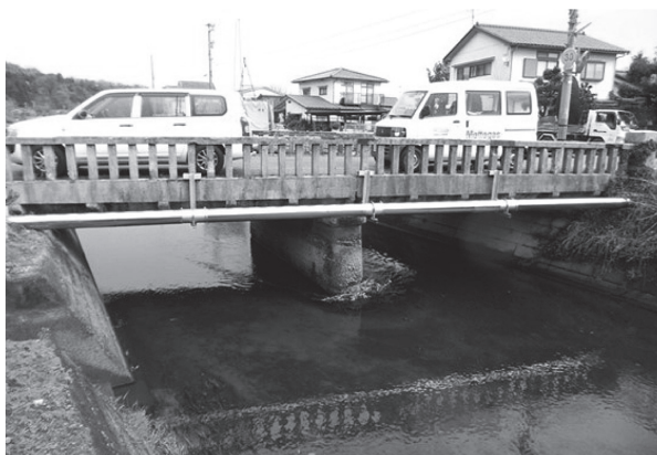
写真 - 4 対象橋梁の外観
