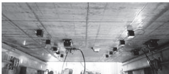
写真 - 2 供試体下面のセンサー設置状況
