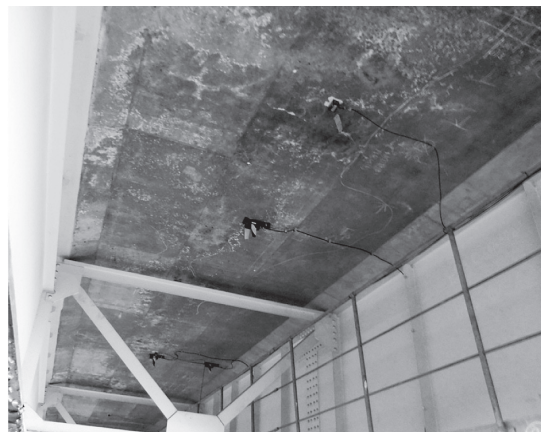
写真 - 3 実橋の床版下面のセンサー設置状況
