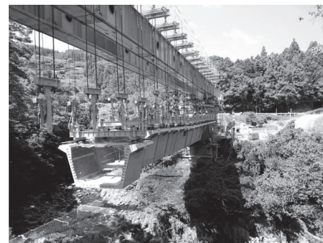
写真-10 架設状況
