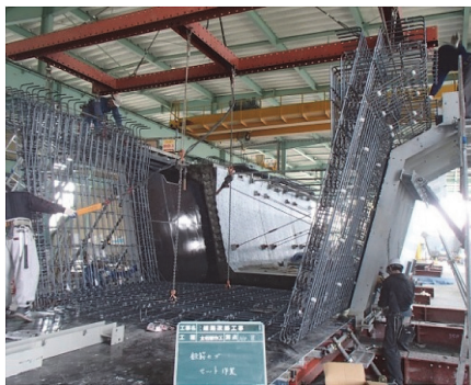
写真 - 3 プレファブ鉄筋型枠設置状況
