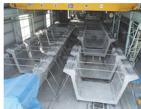
写真 - 4 セグメント仮置き状況
