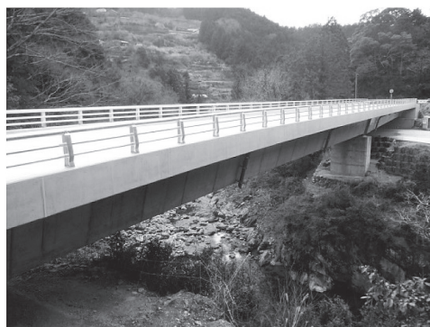
写真 - 12 上分 2 号橋完成写真全景
