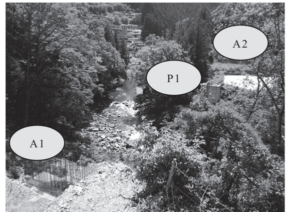
写真 - 1 施工前全景写真
