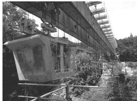
写真-8 吊装置全景
