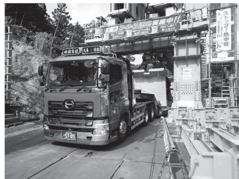
写真-9 セグメント搬入状況
