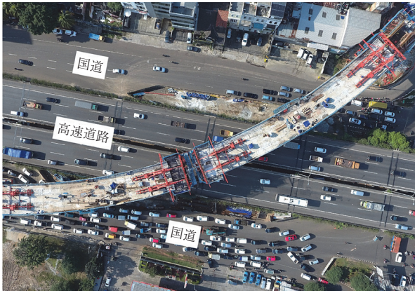
写真 - 5 上空から見た移動作業車を用いた張出し架設工法による架設状況
