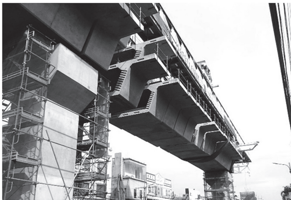
写真 - 3 セグメント吊上げ完了・接合状況
