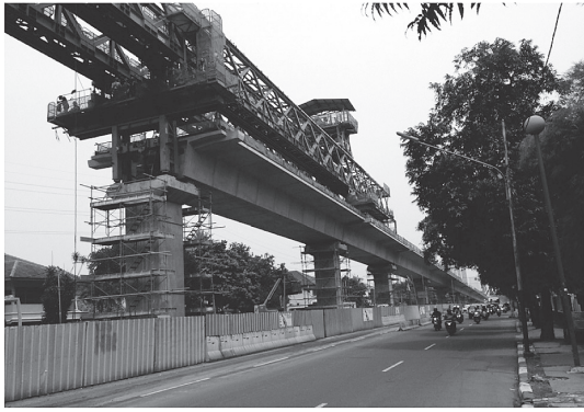
写真 - 4 架設桁によるスパンバイスパン架設
