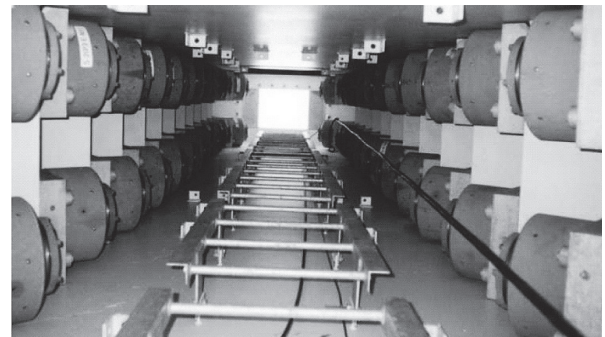
写真 - 4 損斐川橋の塔内部
