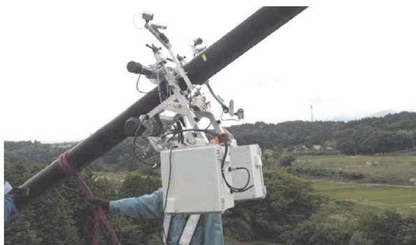
写真-1 自走式点検ロボットによる調査 (東名足柄橋)
