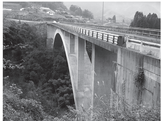
写真 - 12 亀山城橋 (右岸上流から)
