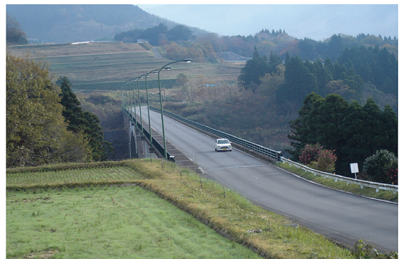
写真-5 国見大橋の周辺
