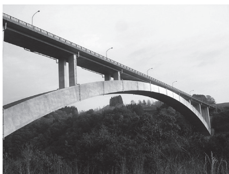
写真 - 2 国見大橋（右岸下流から）
