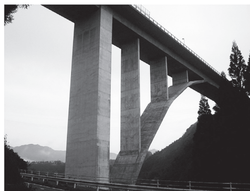
写真 - 8 神都高千穂大橋の橋脚、鉛直材とアーチリブ
