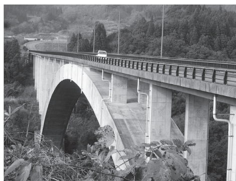
写真 - 1 国見大橋（右岸上流から）
