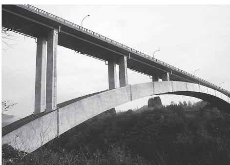
写真 - 3 国見大橋のアーチリブと鉛直材
