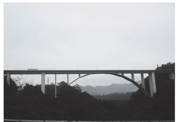
写真-6 神都高千穂大橋(下流から)
