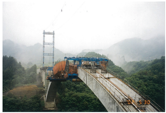
写真-4 国見大橋の建設
