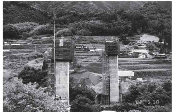
写真 - 13 亀山城橋の建設
