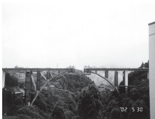
写真 - 9 神都高千穂大橋の建設
