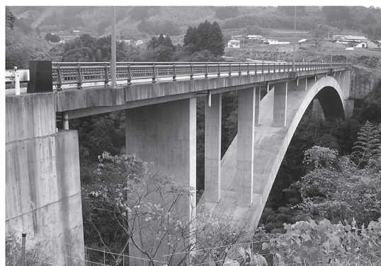
写真 - 11 亀山城橋（右岸下流から）
