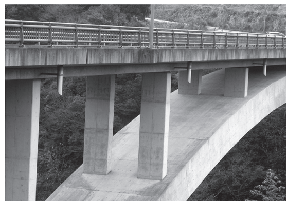
写真 - 15 亀山城橋のアーチリブの滑らかな上面
