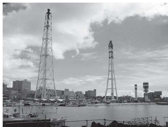
写真 - 1 牧港高架橋の現場より望む
