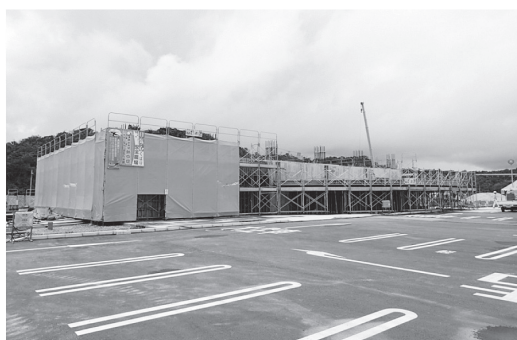
写真 - 7 現場状況
