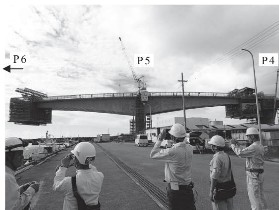
写真 - 3 P5 橋脚張出し架設の工事状況
