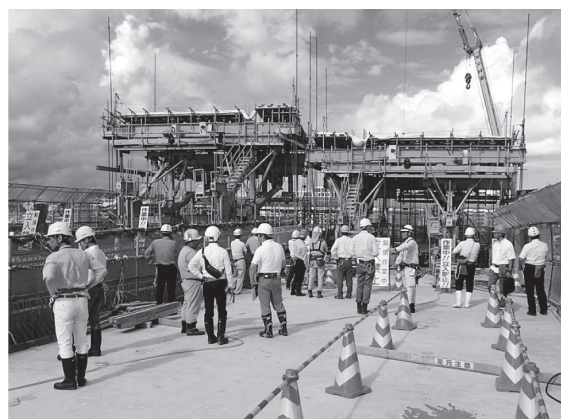
写真 - 5 P5 橋脚の P4 側張出し架設部の移動作業車
