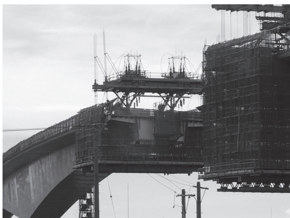
写真 - 4 P6 橋脚の張出し架設部先端の接続桁架設完了状況
