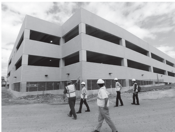
写真 - 6 Parking 建設現場の見学
