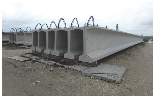
写真 - 5 橋梁のプレテンション I 桁 (Heldenfels 工場)
