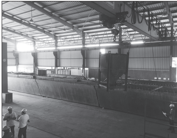
図 - 13 二次養生ヤードでの打設状況
