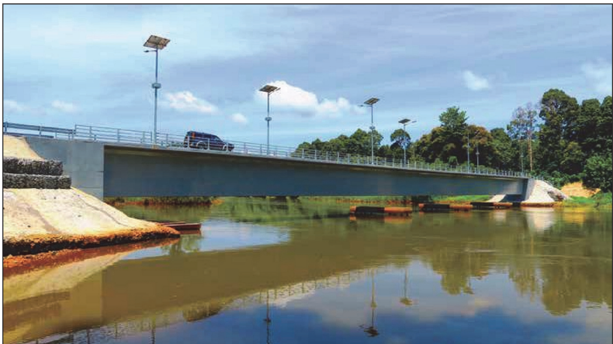
図 - 1 UHPC製のセグメント箱桁橋（マレーシアのペラ州ゲリク）
