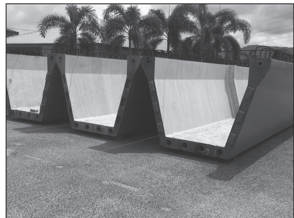
図 - 7 U型セグメント桁の仮置き状況
