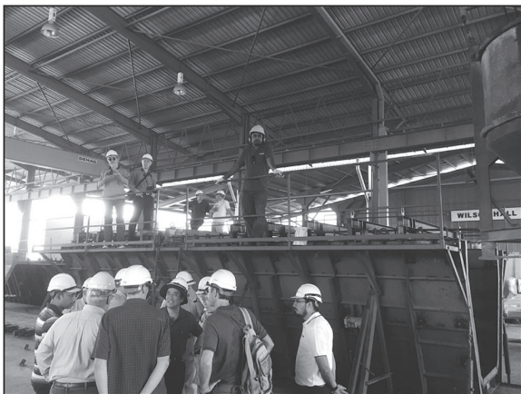
図-5 U型セグメント桁の打設前状況
