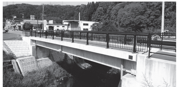
写真 - 6 宮坂橋歩道橋 (石川県)
