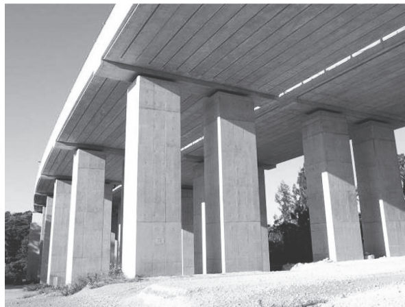
写真 - 6 工場製品と現場打ちの組合せの事例
