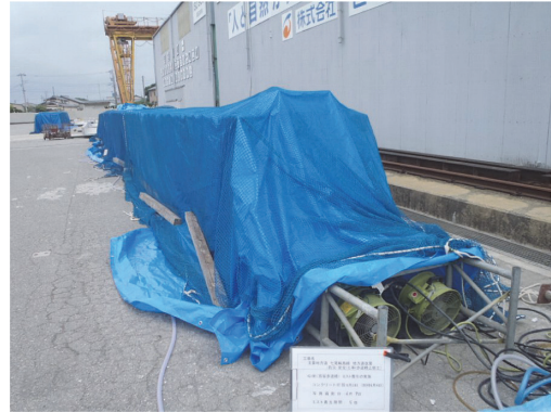
写真 - 1 ミスト養生状況
