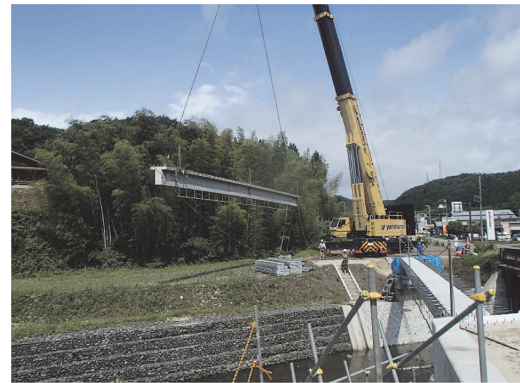
写真 - 2 架設状況
