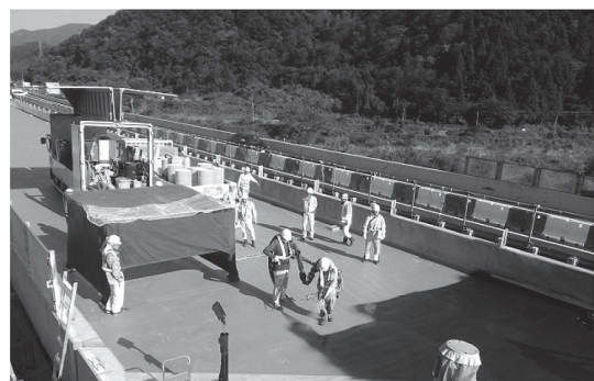
写真 - 8 防水施工状況
