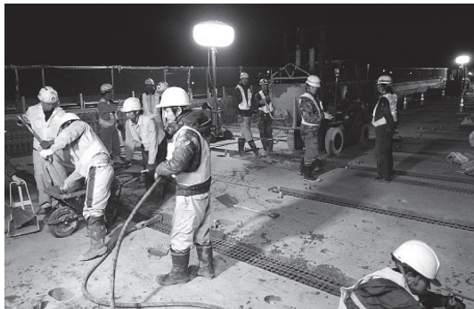
写真 - 9 バケットによる間詰め床版部の打設
