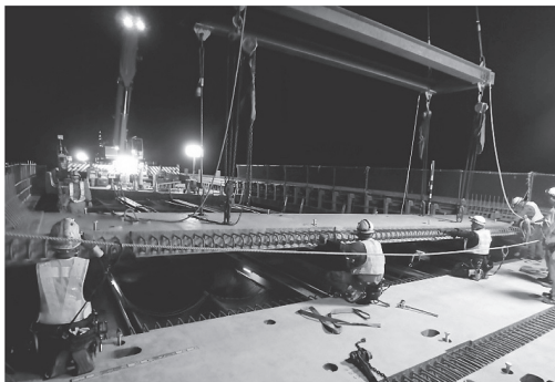
写真 - 5 プレキャストPC床版架設状況
