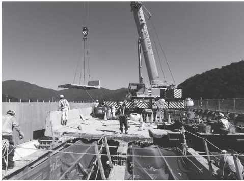
写真 - 4 既設床版剥離，撤去状況
