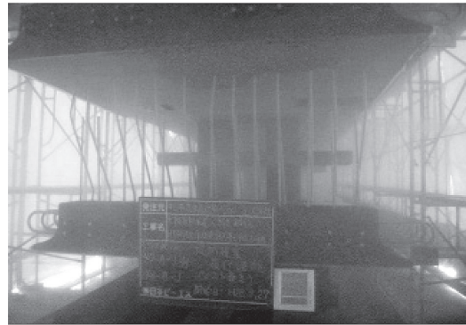
写真 - 10 ミスト噴霧による湿潤養生
