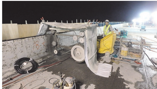
写真 - 3 ワイヤソーによる壁高欄切断状況
