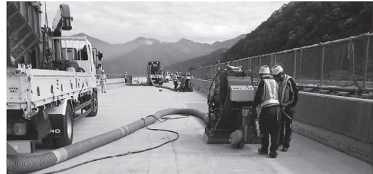
写真 - 6 床版面研掃状況
