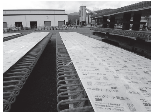
写真 - 11 保水養生テープを用いた封緘養生
