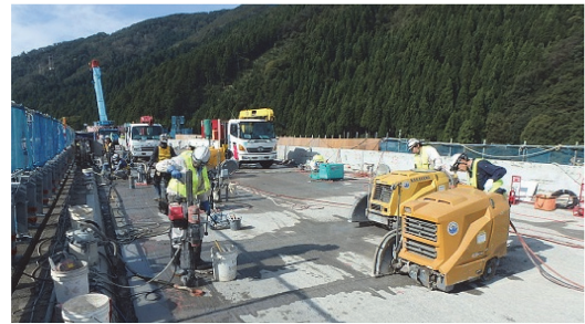
写真 - 2 ウォールカッターによる床版切断状況
