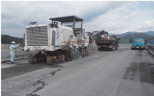
写真 - 1 SF コンクリート切削状況
