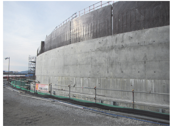
写真 - 2 PC 防液堤コンクリートの脱型後の外観
