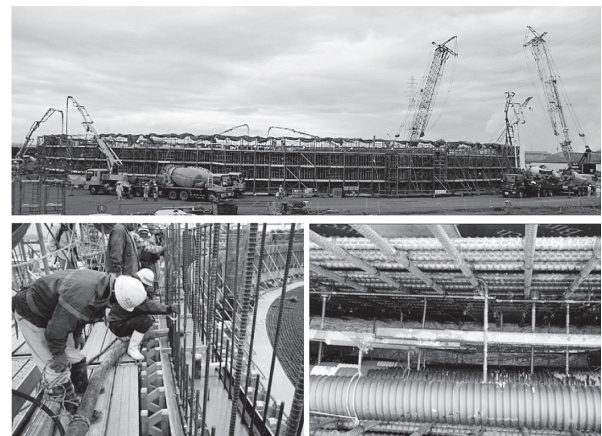
写真 - 1 PC 防液堤コンクリートの施工状況
