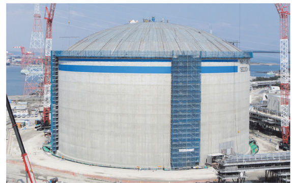
写真 - 3 構築した LNG タンクの外観
