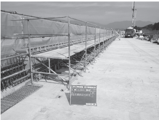
写真 - 10 壁高欄工施工状況
