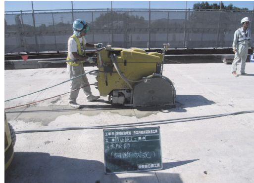
写真 - 7 橋軸方向切断状況 (フラットソー工法)
