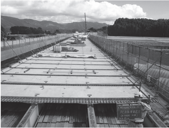
写真 - 9 PCaPC 床版架設完了
