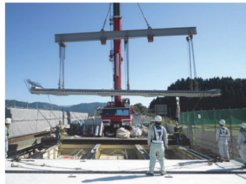
写真 - 8 PC 床版架設状況
