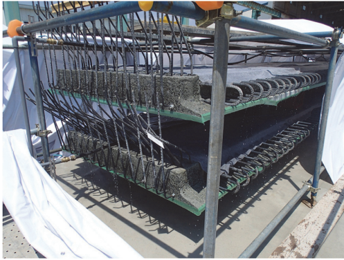
写真 - 6 湿潤養生状況
