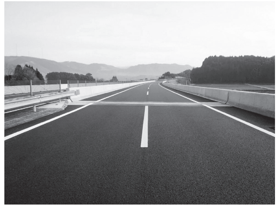
写真 - 12 床版取替え工完了
