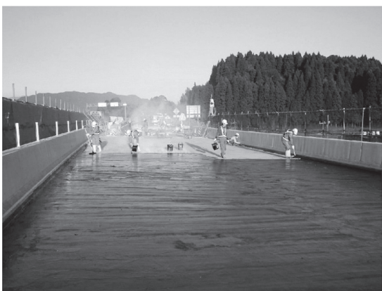
写真 - 11 床版防水工の施工状況
