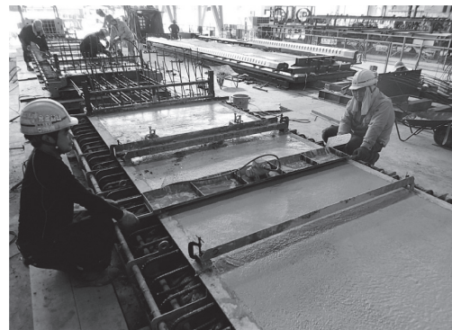
写真 - 5 PCaPC 床版への外部振動状況
