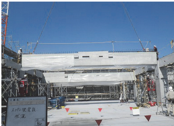
写真 - 5 梁部材架設状況
