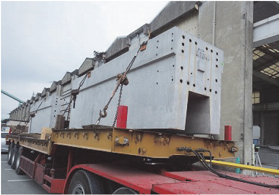
写真 - 3 プレキャスト柱部材出荷状況
