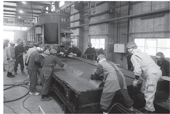
写真 - 2 コンクリート打設状況 (PC 床版)
