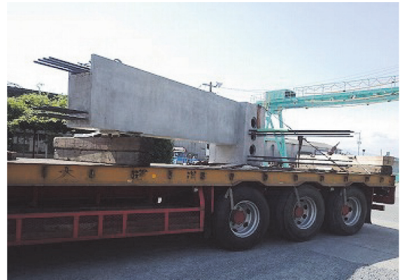
写真 - 4 梁部材（柱付）出荷状況
