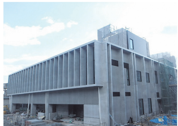
写真 - 7 プレキャスト工事完了外観
