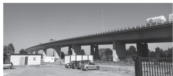
写真 - 14 Saint-André-de-Cubzac 橋 (陸上部)
