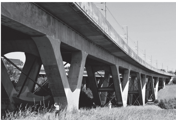
写真 - 8 José 高架橋
