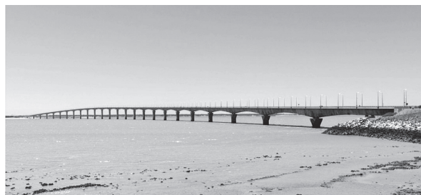
写真 - 17 Re Island 橋
