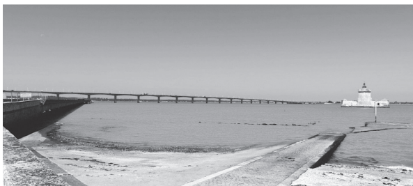
写真 - 15 Oleron 高架橋
