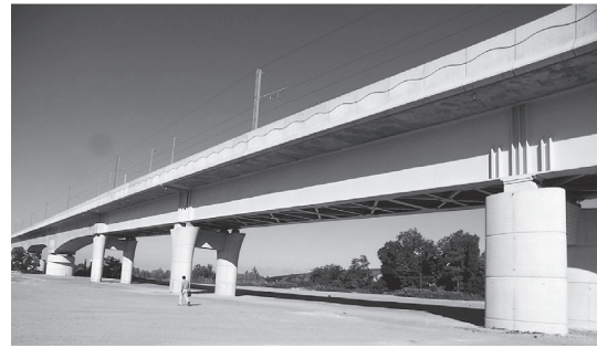
写真 - 12 Cubzac 高速鉄道橋 (鋼桁部)
