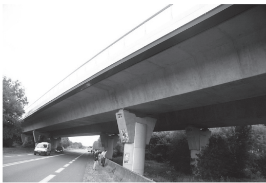
写真 - 10 Barrails 高架橋
