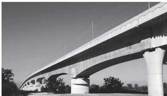
写真 - 11 Cubzac 高速鉄道橋 (PC 桁部)
