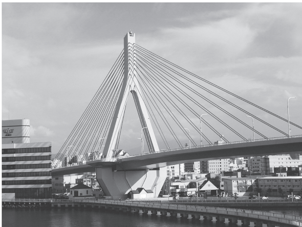
写真-1 青森ベイブリッジの主塔
