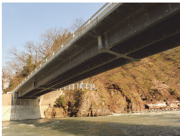
写真 - 4 小滝川橋 (鹿島建設(株)よりご提供)
