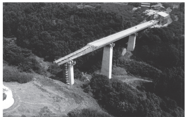
写真-2 榛名フルーツライン榛名10号橋の押出し施工
