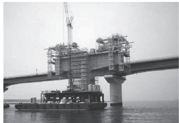
写真 - 2 エレクションノーズによる張出し架設例 2)
