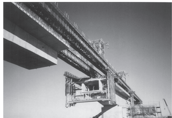
写真 - 1 架設桁によるバランスドカンチレバー架設例 3)
