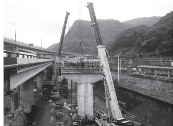
写真 - 10 トラッククレーンによる架設状況
