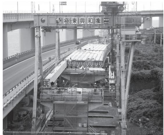
写真 - 11 自走式門型クレーンによる架設状況
