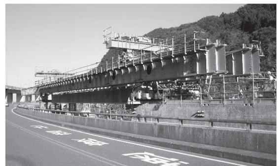
写真 - 12 抱込み式架設桁横取り方式による架設状況
