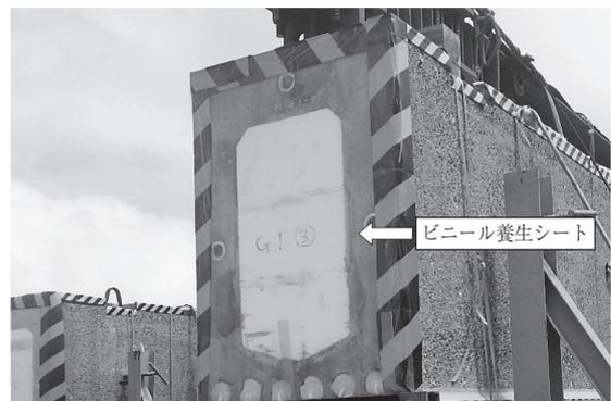
写真 - 3 運搬時のセグメント接合面養生状況
