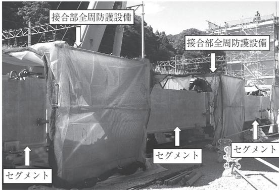
写真-5 セグメント接合面の全周防護設備
