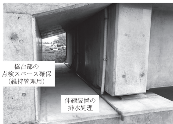
写真 - 4 維持管理性の高い桁端部
