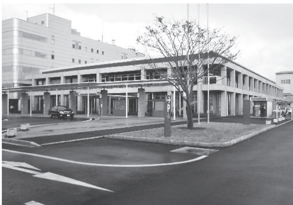
写真 - 3 山梨市庁舎
