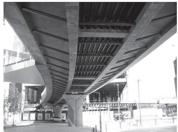
写真 - 4 高強度 PC 鋼材の適用事例（外ケーブル）
