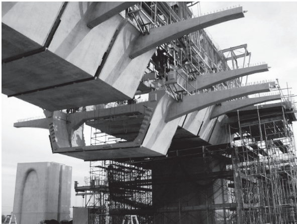
写真 - 2 プレキャストセグメント工法
