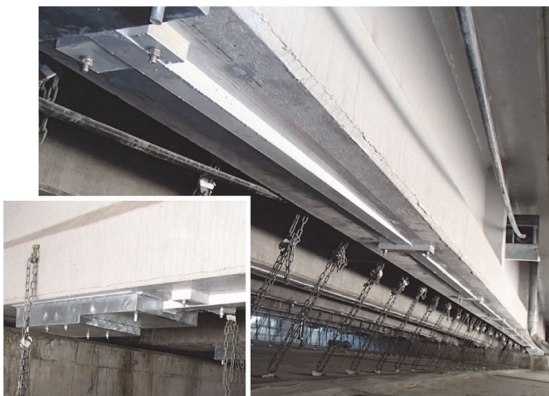
写真-3 炭素繊維プレートを緊張材に使用した事例
