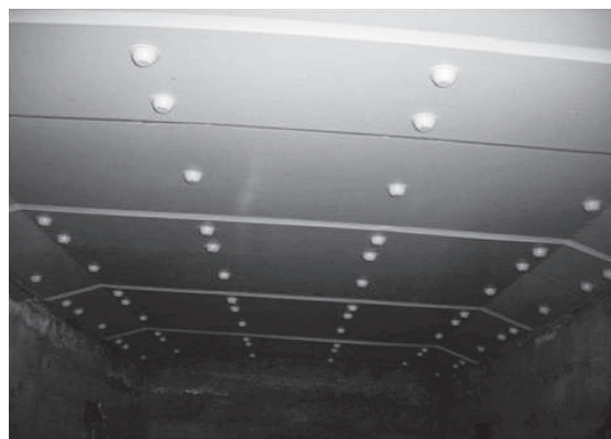
写真 - 7 鋼板接着工法による床版補強
