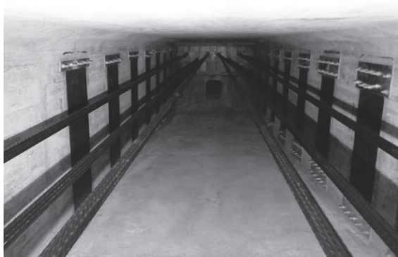
写真 - 4 PC 箱桁のせん断補強
