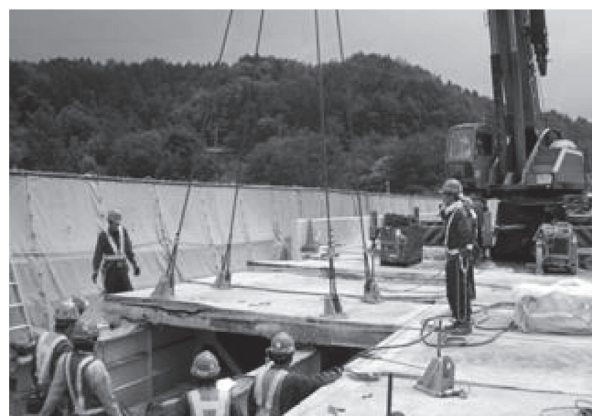
写真 - 10 既設 RC 床版の撤去状況
