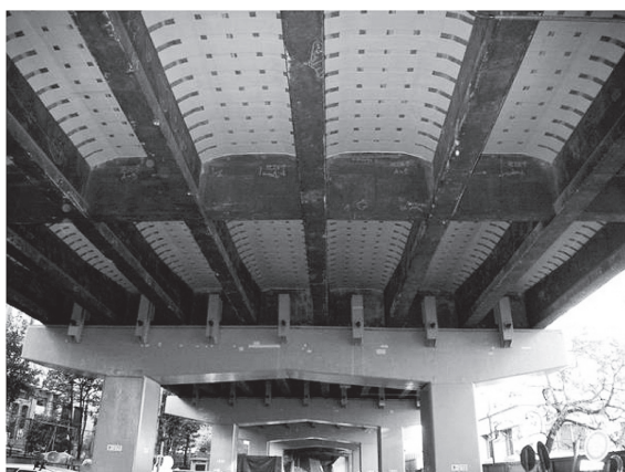
写真 - 5 RC 床版の疲労耐久性向上対策
