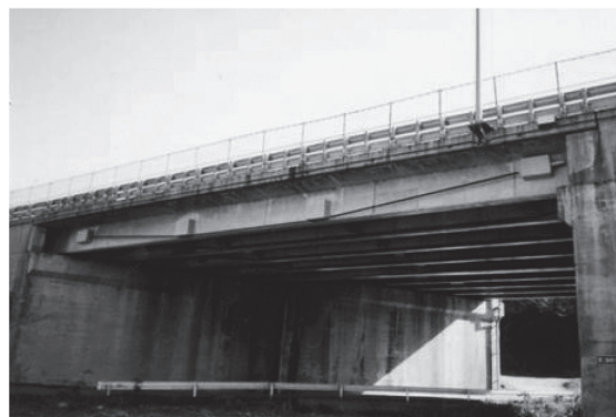
写真-1 外ケーブルによるB活荷重対策事例
