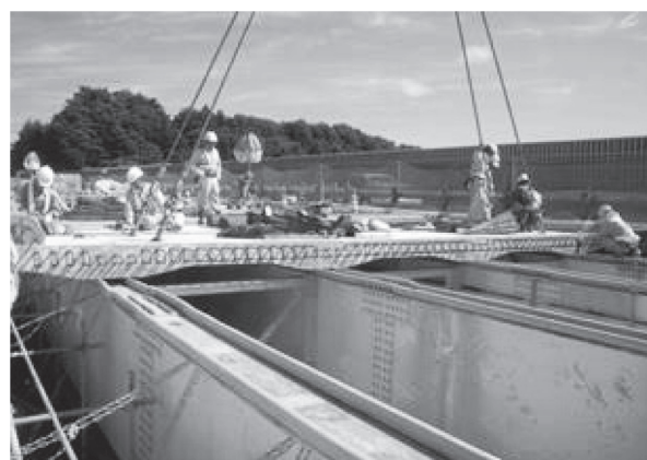
写真 - 11 プレキャスト PC 床版の架設状況
