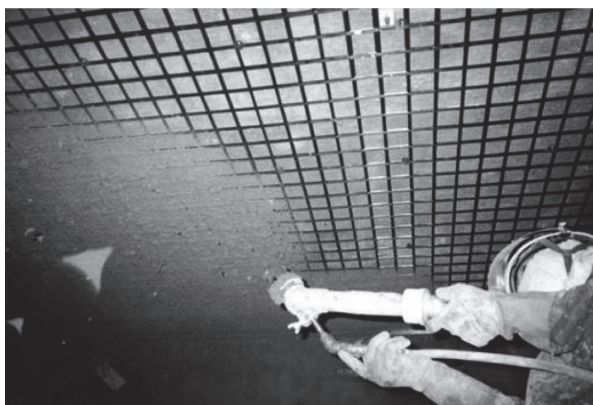
写真 - 9 ポリマーセメントモルタル吹付け状況
