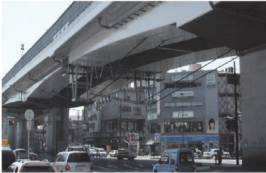
写真-2 外ケーブルによるたわみ抑制対策事例
