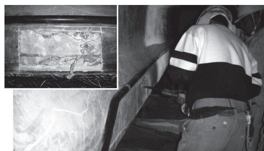
写真 - 1 オーバーレイモルタルのはつり状況
