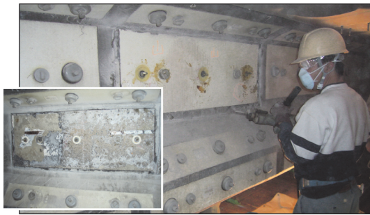
写真 - 2 パネルの解体状況
