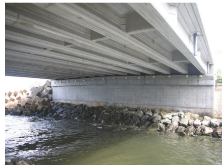
写真 - 3 本工事を行った橋梁 (完成写真)
