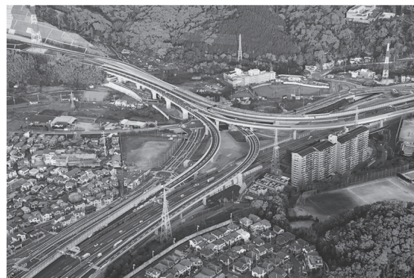
写真 - 1 高槻 JCT・IC 付近の状況
