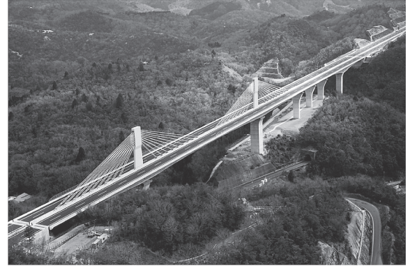
写真 - 3 生野大橋の全景写真
