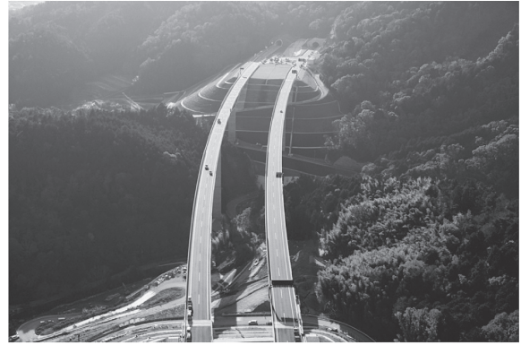
写真 - 6 佐保川橋の全景写真
