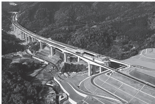
写真 - 8 楊梅山高架橋の全景写真
