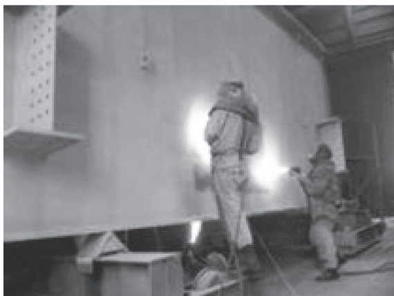
写真 - 14 金属溶射の施工状況
