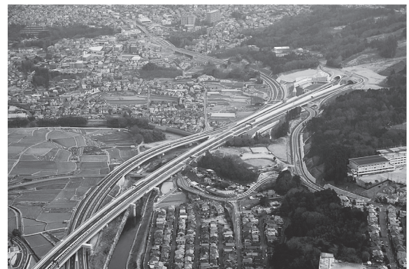
写真 - 4 一庫大路次川橋の全景写真
