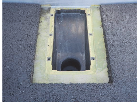
写真 - 20 シーリングの施工状況
