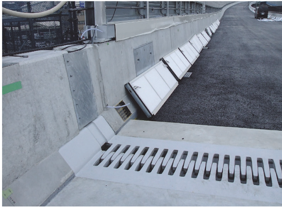
写真 - 17 伸縮装置表面の防錆状況
