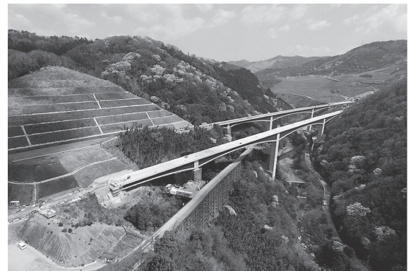
写真 - 7 安威川橋の全景写真
