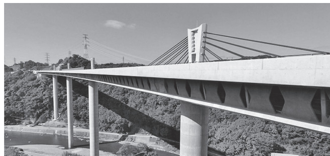
写真 - 10 武庫川橋の近景写真
