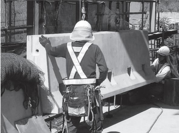
写真 - 4 プレキャスト壁高欄の設置状況
