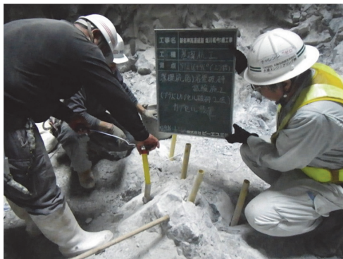
写真 - 5 低振動破碎工法施工状況
