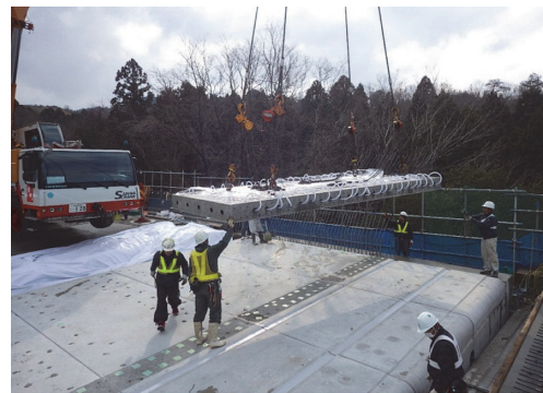
写真 - 6 プレキャスト延長床版架設状況
