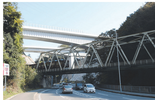
写真 - 8 完成写真
