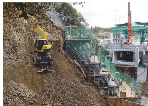
写真 - 7 クライミングバックホーによる掘削状況
