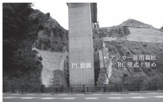
写真-1 上り線P1の土留め構造
