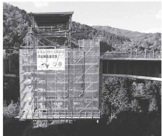
写真 - 2 移動作業車
