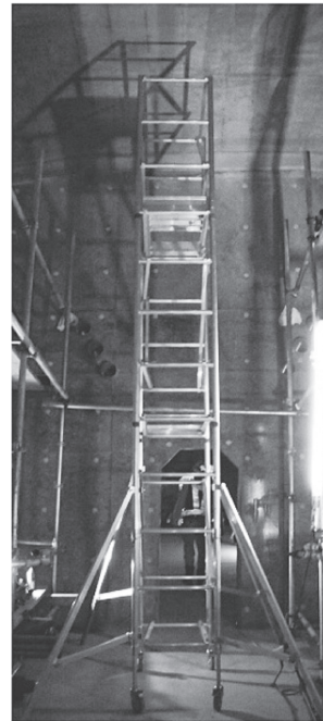
写真 - 9 点検用移動足場
