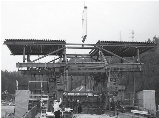
写真 - 4 波形鋼板ウェブ取込み状況
