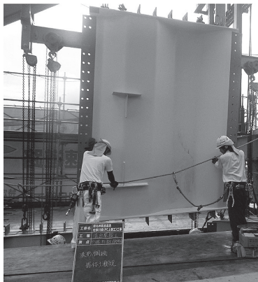
写真 - 5 波形鋼板ウェブ架設状況
