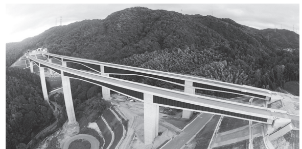
写真 - 10 完成写真
