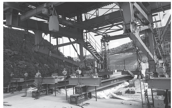
写真 - 6 セッティングビーム設置状況
