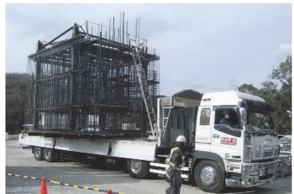
写真 - 4 プレファブ鉄筋の場内運搬状況
