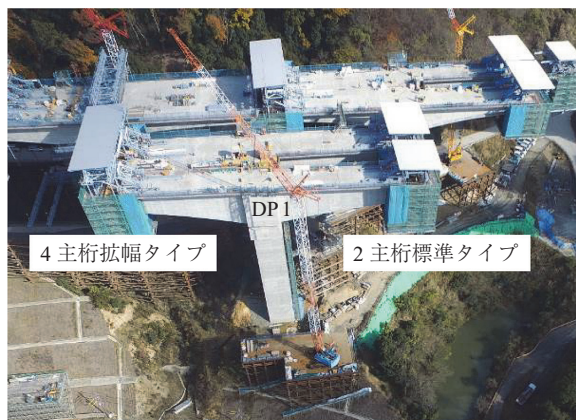
写真 - 2 DP1の張出し施工状況
