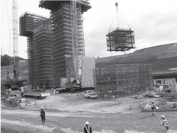
写真 - 5 プレファブ鉄筋吊上げ状況
