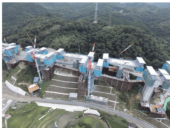
写真 - 3 最盛期の張出し施工状況
