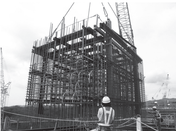
写真 - 6 プレファブ鉄筋設置状況
