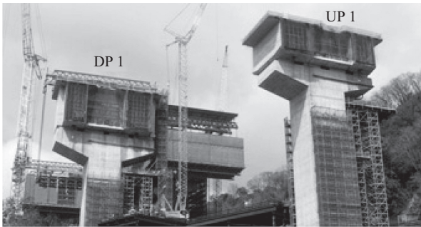
写真 - 1 3室箱桁部の主桁断面
