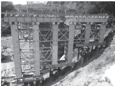
写真 - 2 急峻斜面への杭基礎支保工施工状況
